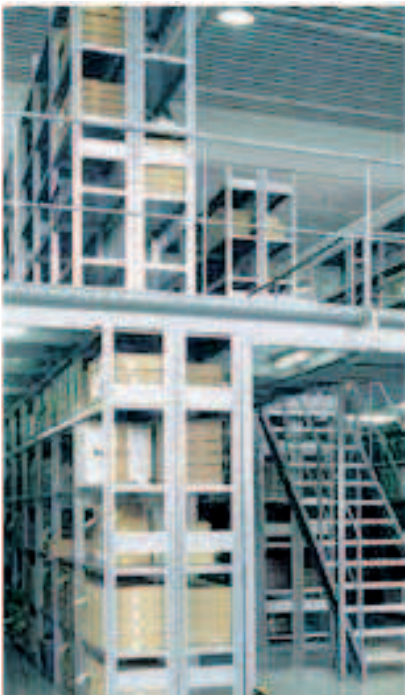
Estantería paneles en varios niveles
