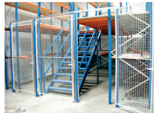
Escalera de acceso a entreplanta con cierre metálico.
