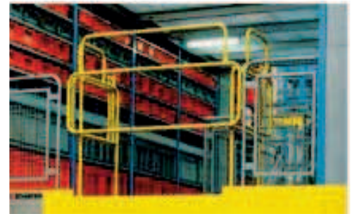
Barandilla de acceso a entreplanta
