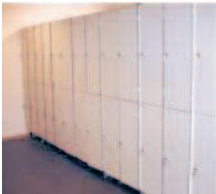
Instalación de taquillas
