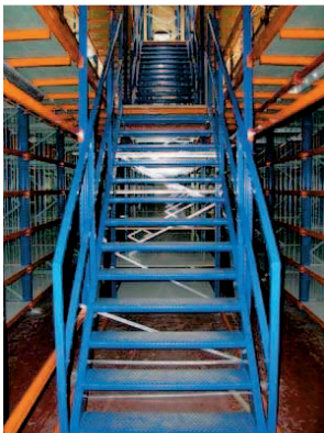
Escalera de acceso a entreplanta
